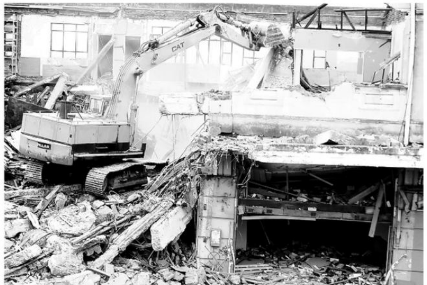
LAS PLAZAS Y OREJAS DE CONEXIONES VIALES son algunos de los lugares en que el grupo de profesionales pretende trabajar para recuperar la memoria histórica de la ciudad, a pesar de la destrucción que generan los terremotos.
